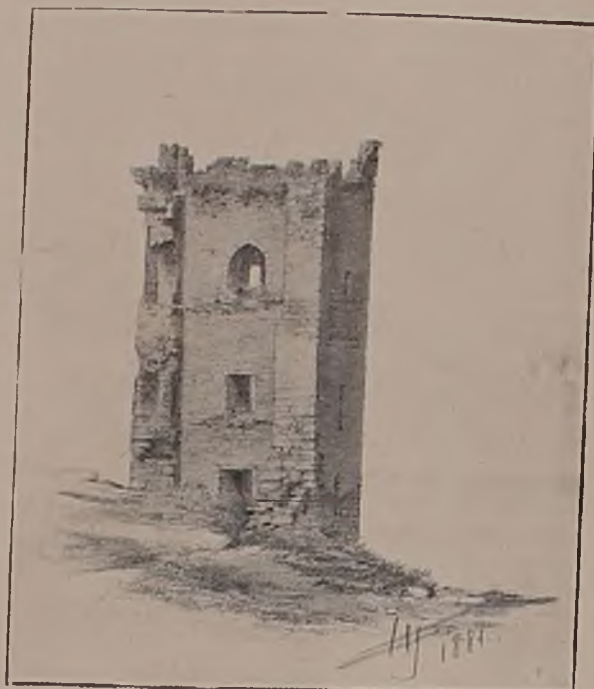
SOLDAIA — Avanzo d'una torre a sud
