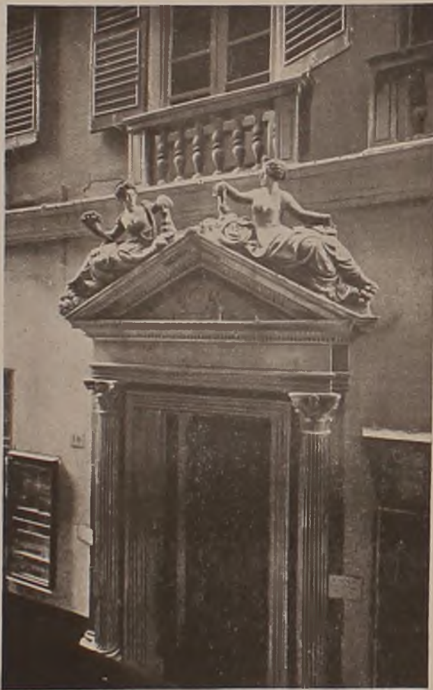
Portale del palazzo Grimaldi in via S. Luca dove alloggiò R. Wagner nel 1853
