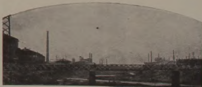
Una selva di alti camini fiancheggia il torrente.
