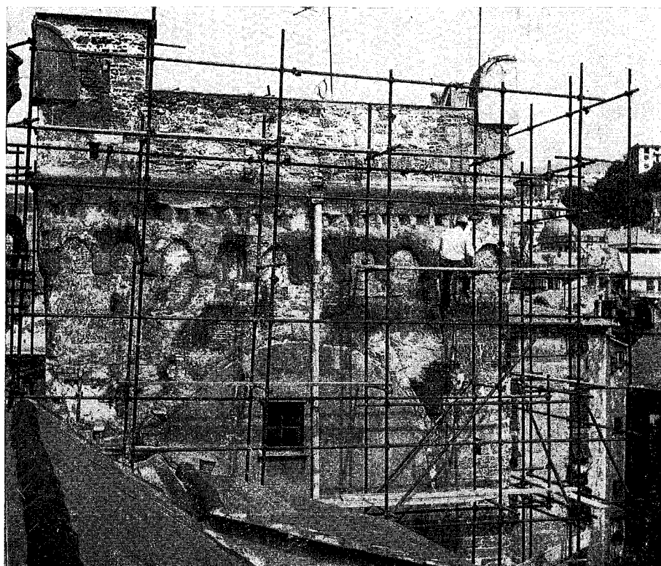
9. — Parte terminale interna della torre a mare, durante i lavori. - Il grande arcone murato che si apriva sulla piazzuola terminale della torre, nel suo incerto sesto, è realizzato con una tecnica costruttiva che oggi noi giudicheremmo imperfetta. I conci, anziché a cuneo con il piano del « verso » della pietra perpendicolare alla linea di pressione, (e cioè alla tangente dell'arco), sono disposti « di punta », cioè verso il parallelo alla linea delle pressioni. Tale disposizione, ovviamente imperfetta dal punto di vista statico, risulta più economica e più speditiva, soprattutto in relazione allo sfaldamento dei blocchi di pietra. Il sistema costruttivo si ritrova in alcune arcate dei portici di Chiavari anch'essi del sec. XII. La nostra figura chiarisce il sistema di restauro e giustifica la ricostruzione del toro alla sommità della cornice ad archetti pensili, attuata per riparare i muri esterni e non per realizzare un restauro integrativo.
