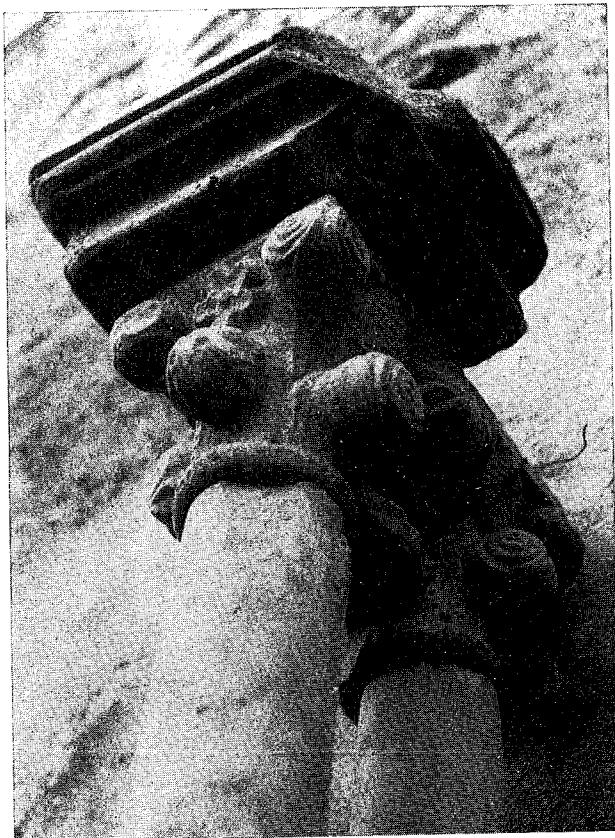
3-5. — I capitelli binati, in marmo, lavorati a scalpello, con cornici in serpentino locale (cm. 31 x 20 x 15).
