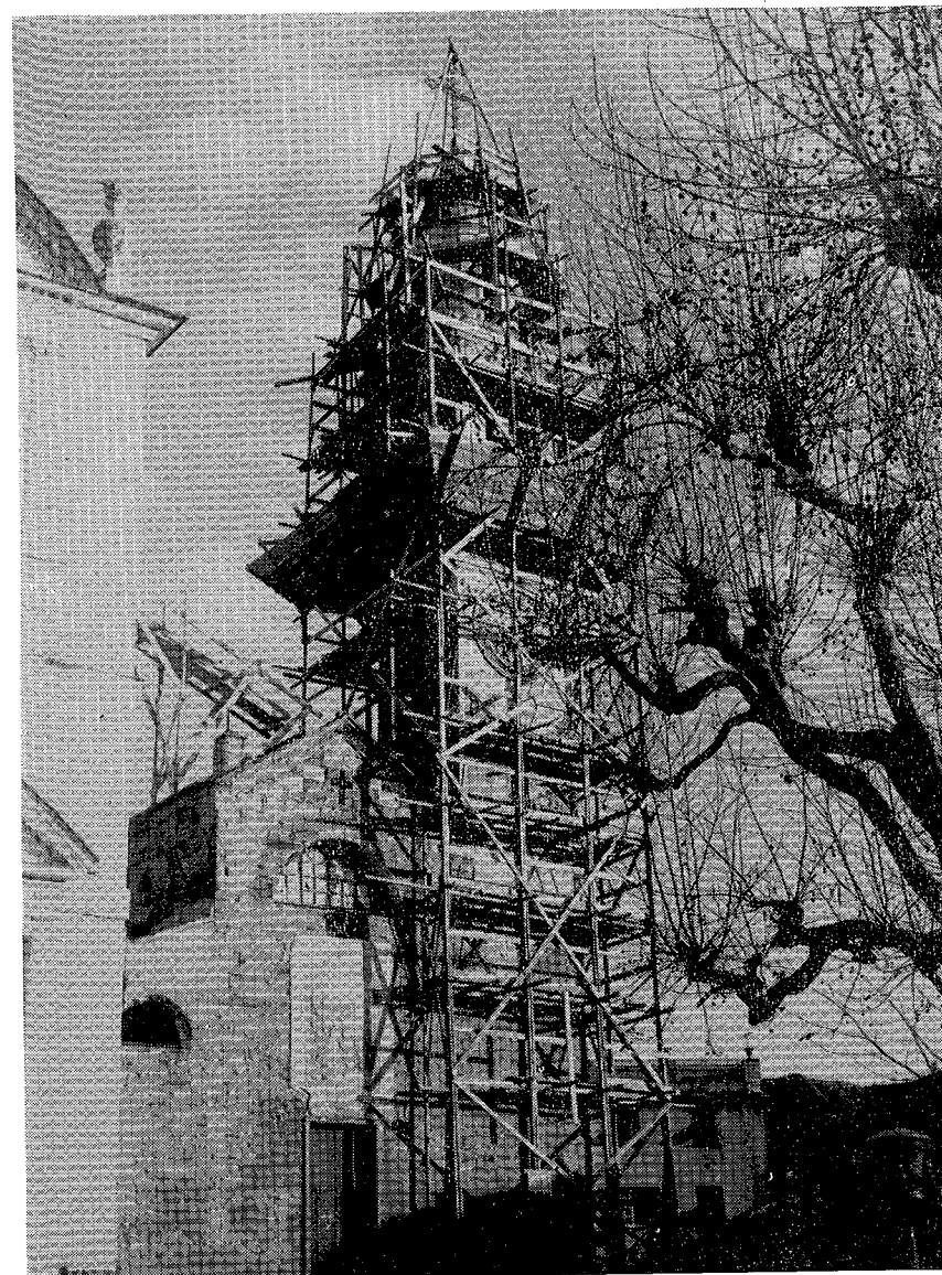
32. — Un documento molto sintomatico dell'umile facciata in corso di restauro, col muro a pietra vista già ripristinato, ma ancora conservate le due lunette (la terza ovviamente era dipinta) e l'affresco, caro alla pietà dei fedeli; e del maestoso campanile, che, ingabbiato nelle impalcature dell'impresa che provvede al suo integrale restauro, appare anche più imponente. Il tutto tra le cortine da un lato della bianchissima chiesa nuova, dall'altro di un albero secolare che l'inverno, spogliandolo, ha reso più pittoresco ed aggressivo.
