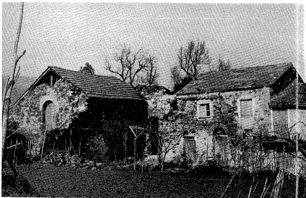
20. — Chiesa e monastero da sud-ovest dopo i primi restauri: la porta della chiesa è ricomposta e sono messi in evidenza gli elementi originari delle bifore e l'arco della porta della Sala Capitolare.
