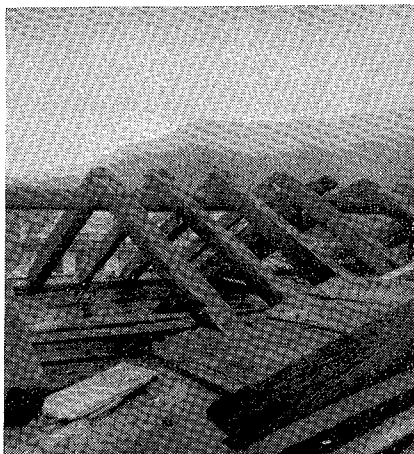
15. — La grossa orditura del tetto antico durante il restauro.
