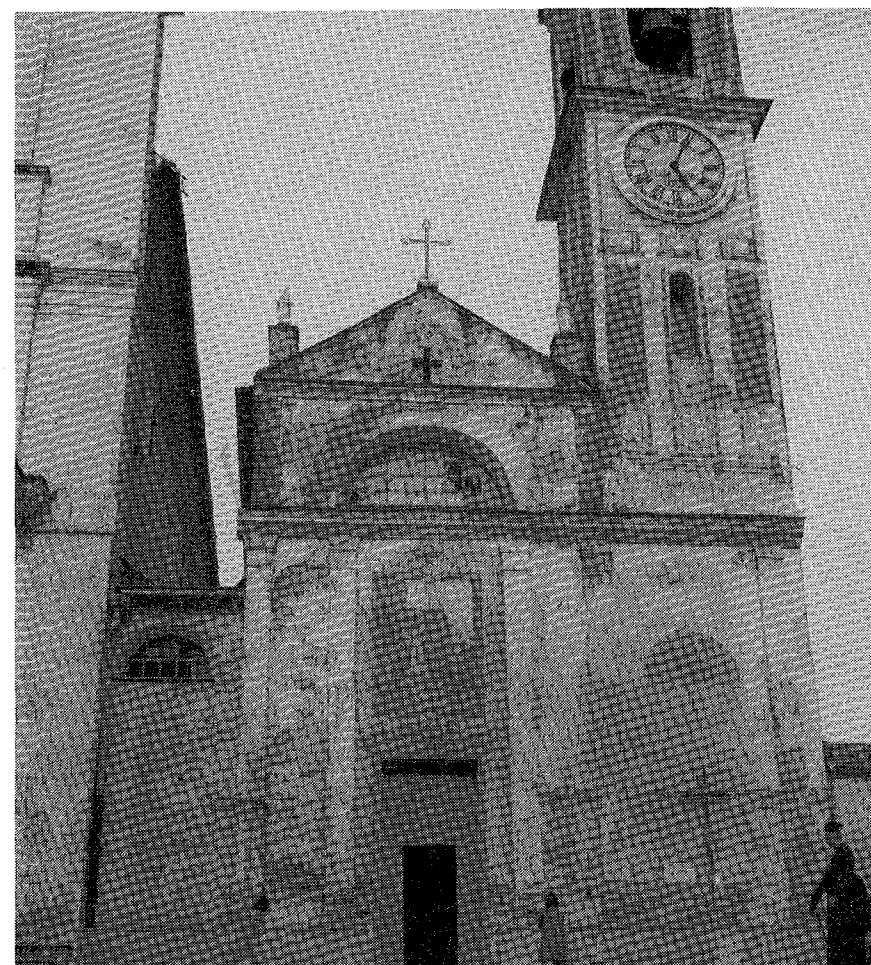
9. — La facciata del vecchio S. Ambrogio nel 1940, quale appariva prima degli ultimi restauri presso la chiesa nuova che incombe a sinistra, morticata nel fastigio e nel respiro dell'ala a monte con la sopraelevazione del muro d'ambito in funzione della nuova fabbrica. A destra, presso il campanile, l'alta figura di Mons. Benvenuto.
