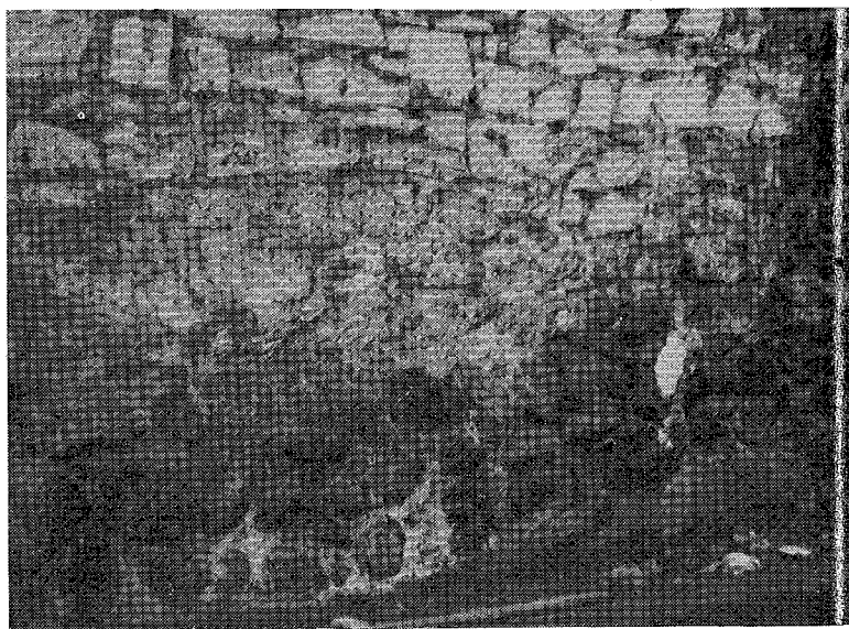
8. — Un campione della muratura arcaica di ciotoli di fiume cementati con malta, alla base del muro « romanico », in cui si notano pietre lavorate, forse di reimpiego, nella parete di levante e sotto l'abside.
