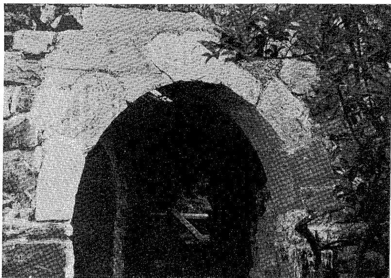
24. — L'arco di porta ricomposto in parte coi conci originari recuperati. I conci mancanti sono suppliti con cemento a vista.
