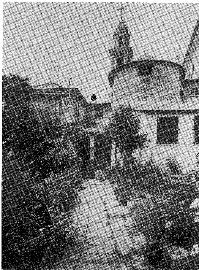
42. — Il corpo della nuova sacristia nel quadro del complesso absidale (presbiterio settecentesco e canonica), visto dall'«orto» tipicamente ligure della canonica stessa.
