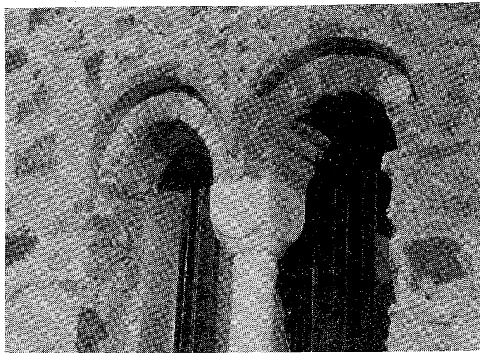
30. — La bifora di sinistra, ripristinata con l'inserimento di una colonnina di restauro, eseguita sul modello della superstita di destra, deliberatamente senza ornati; ma il lapicida non ha saputo rinunciare ad esprimere una sua sensibilità nettamente difforme.
