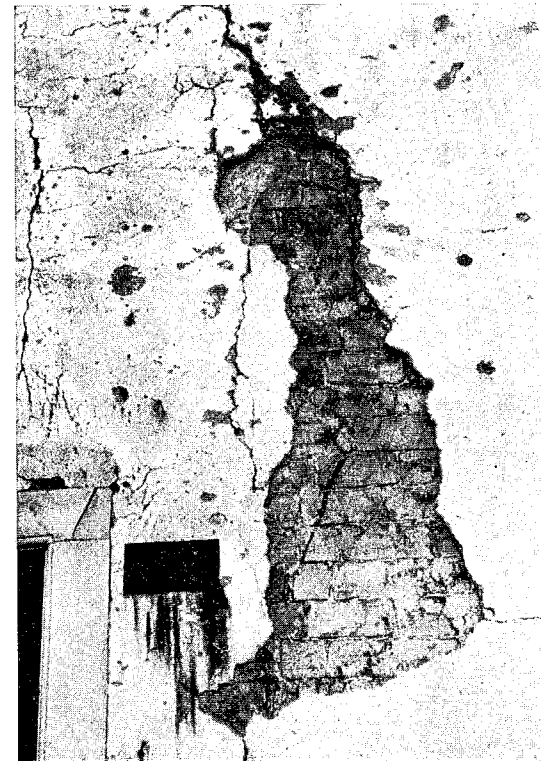
5. — Il paramento di pietra lavorata apparso in seguito alla caduta dell'intonaco.
