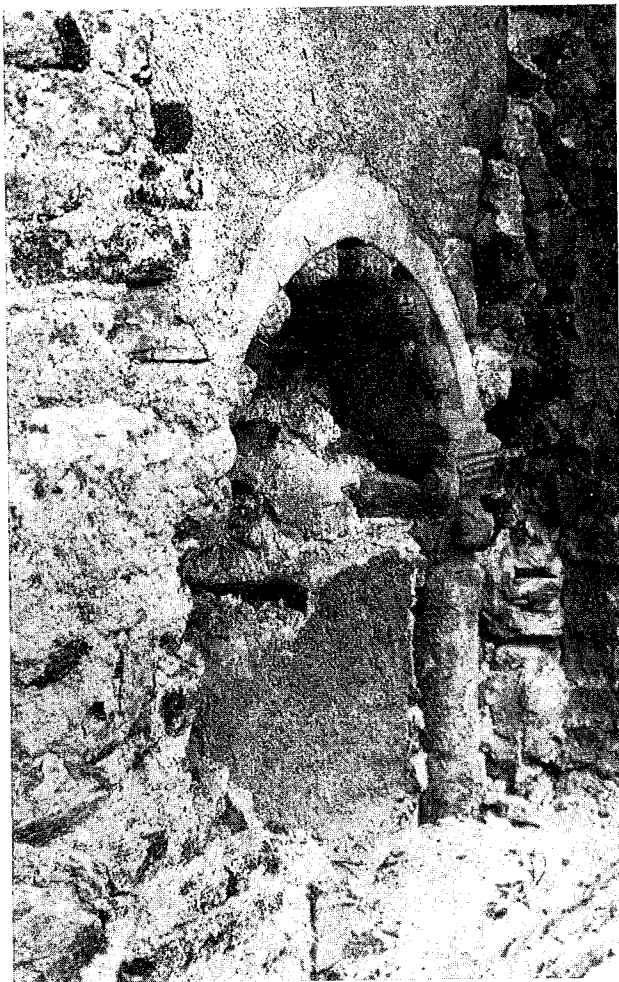
13. — Archetti di una trifora, con capitello e colonnina, durante lo scoprimento. Rivela il riattamento seguito all'incendio dell'edificio medioevale: l'intonaco sopra l'archetto copre la lastra di ardesia decorata con apertura quadriloba e motivi a graffito, mentre lo sgancio che dalla colonnina si ritira nello spessore del muro è indizio di un restauro arbitrario che, non riproducendo la trama originale ma riducendo le dimensioni delle aperture, ha preparato le più radicali modifiche secentesche.
