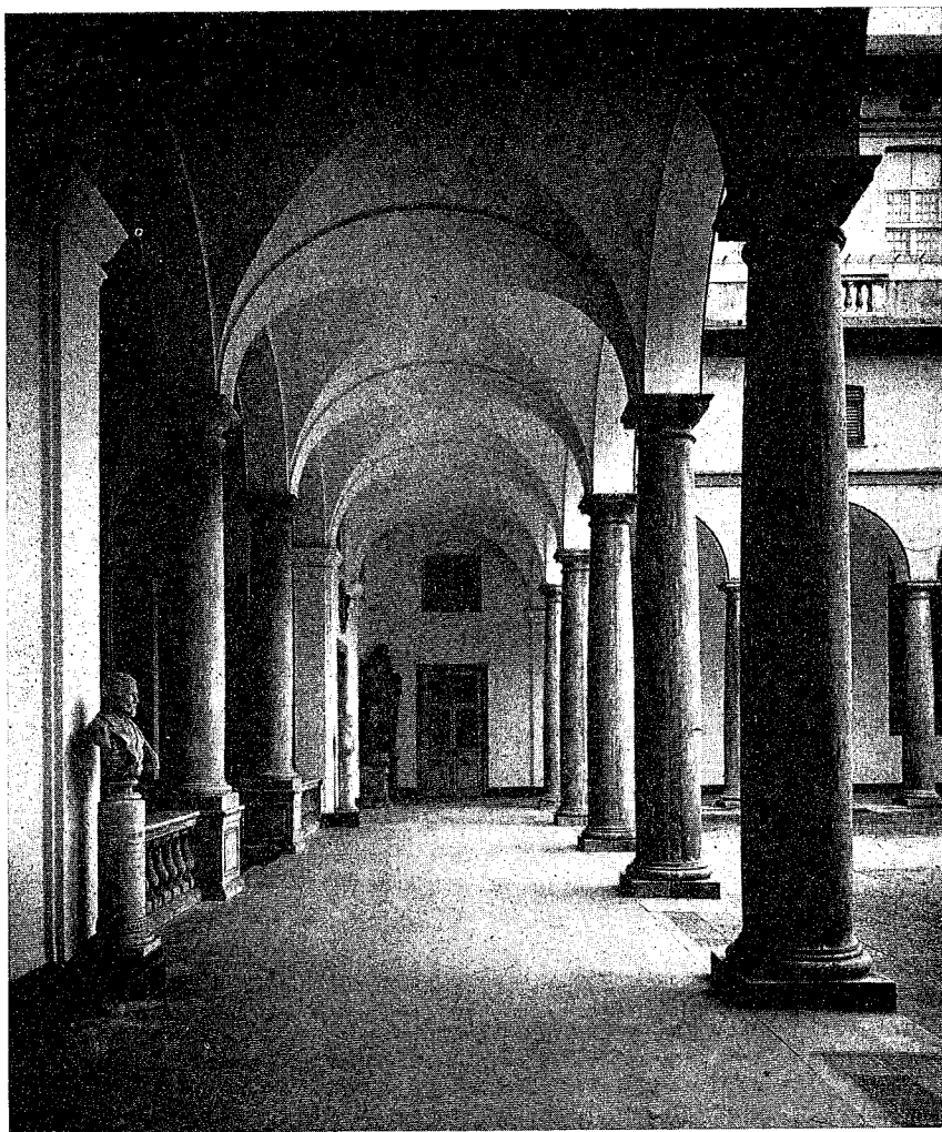
4. — Il braccio anteriore del porticato, al sommo dello scalone di accesso.
