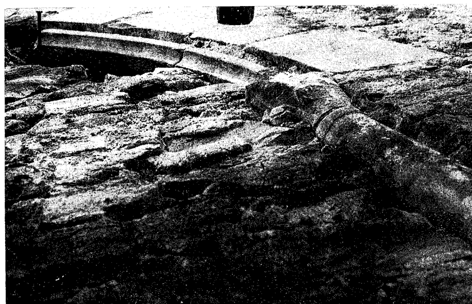
12. — Membrature marmoree di una trifora riaffiorante dalle murature.
