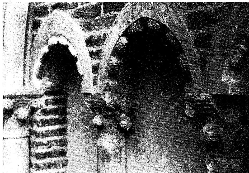
16. — Archetti e capitelli di una trifora dopo il restauro.
