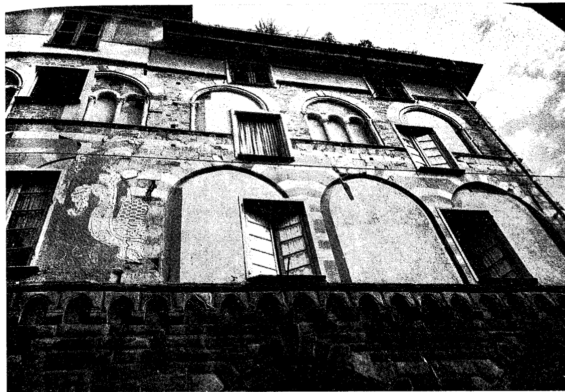
18. — Parte della facciata nei piani superiori dopo il restauro.
